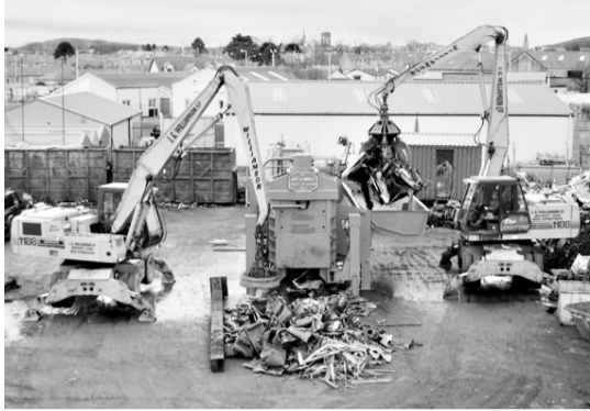
移動式なので基礎工事は不要
